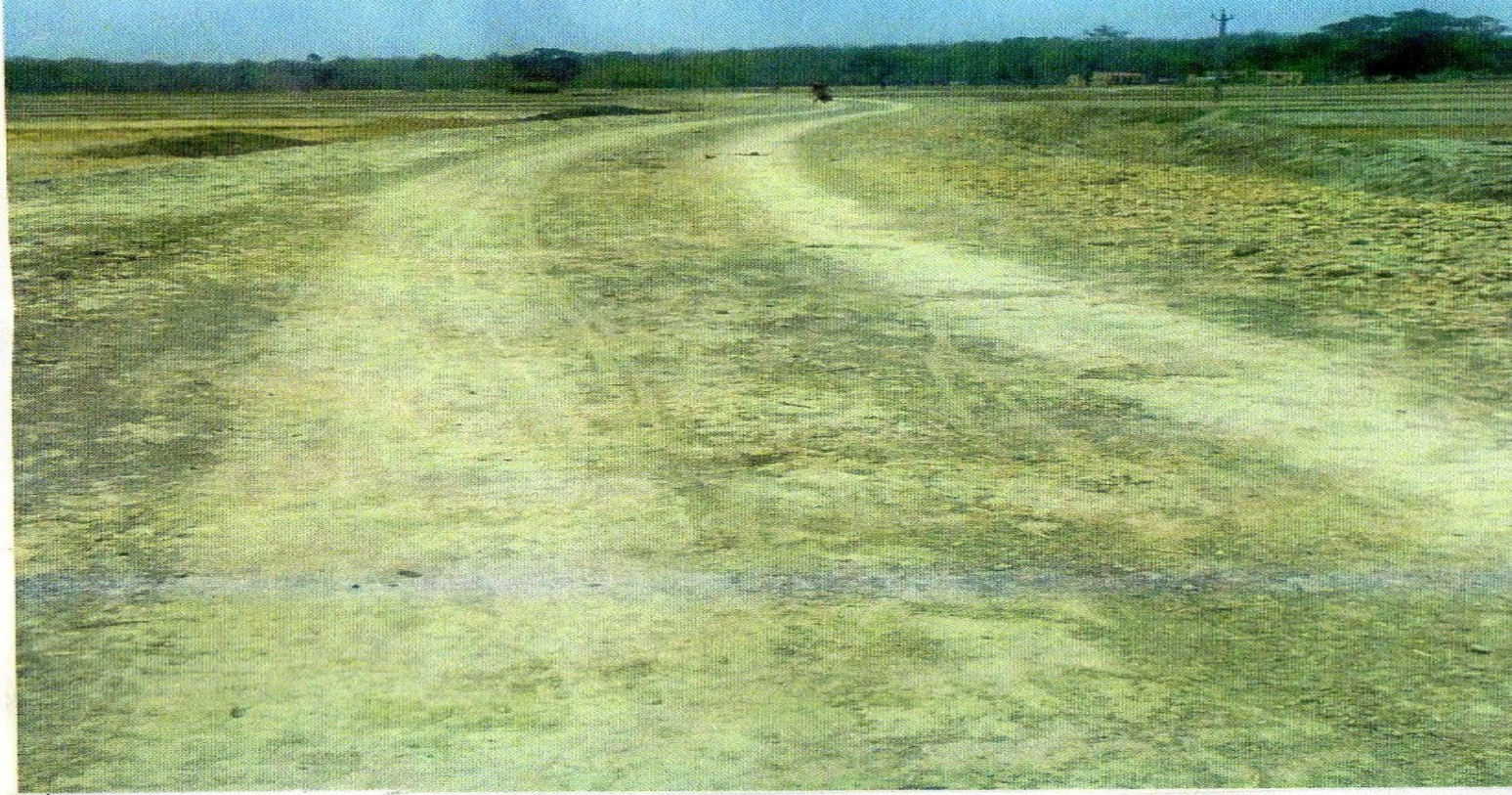
पी0डब्लू0डी0—ग्राम पंचायत असनहरिया मजरा पसियनपुरवा में स0मर्गा निर्माण ।
